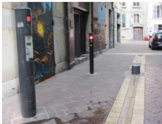
Installation de doubles feux de position de la borne (Grenoble)
