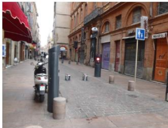
Une entrée d'aire piétonne équipée du dispositif de contrôle d'accès : totem, feu, bornes escamotables automatiques et signalisation (Toulouse).
